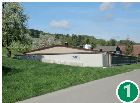
Halle d'engraissement de volaille et entrée d'air
